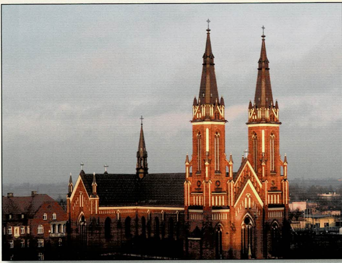
Kościół pw. NMP Różańcowej – widziany z góry fot. Aleksandra Tłoczek
