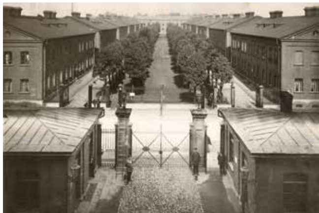
Brama wejściowa do osiedla domów rodzinnych dla robotników na Księżym Młynie. Fot. z Archiwum Państwowego w Łodzi, 1914 r.
