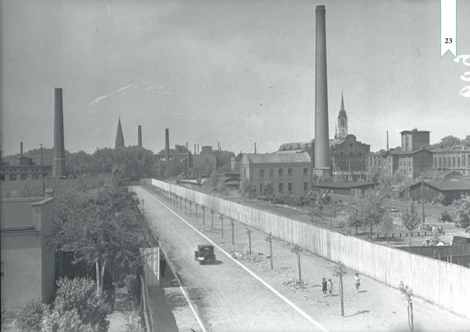
Widok na elektrownię przy ul. Milionowej w Łodzi Fot. Włodzimierz Pfeiffer ze zb. APL, 1937 r.
