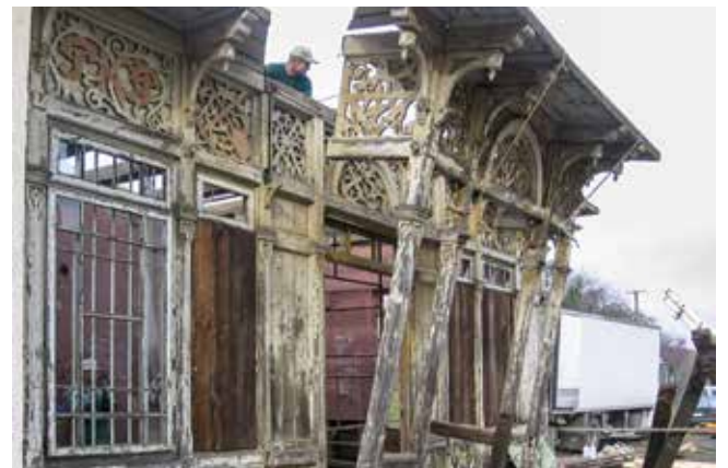
Rozbiórka zabytkowej poczekalni w 2006 r. Fot. arch. Andrzeja Kobalczyka
