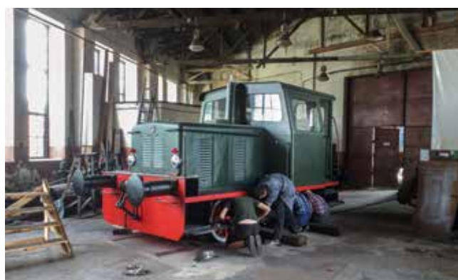
Remontowana lokomotywa spalinowa Ls60-143 Fot. Ariel Ciechański
