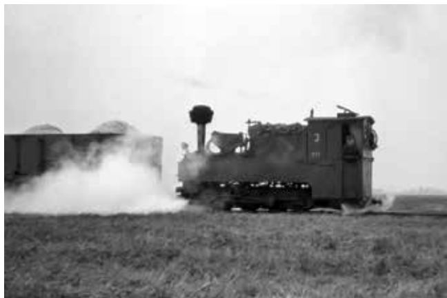
Kolej cukrowni „Leśmierz” Fot. Tomasz Wach
