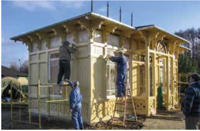
Odbudowa poczekalni w tomaszowskim skansenie Fot. arch. Andrzeja Kobalczyka
