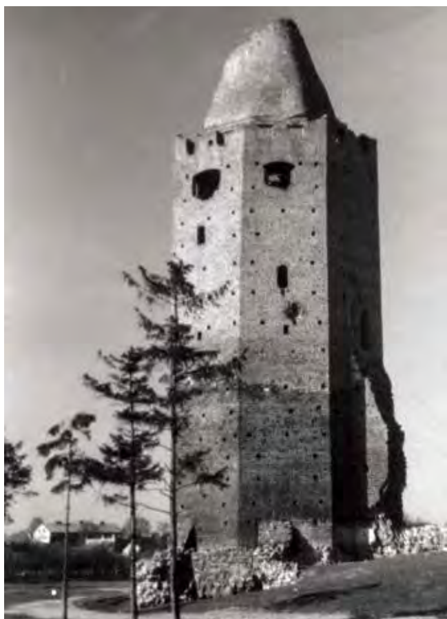
Zamek Książąt Mazowieckich w Rawie Mazowieckiej Fot. Zbigniew Jarzyński, 1954 r., arch CFK PTTK
