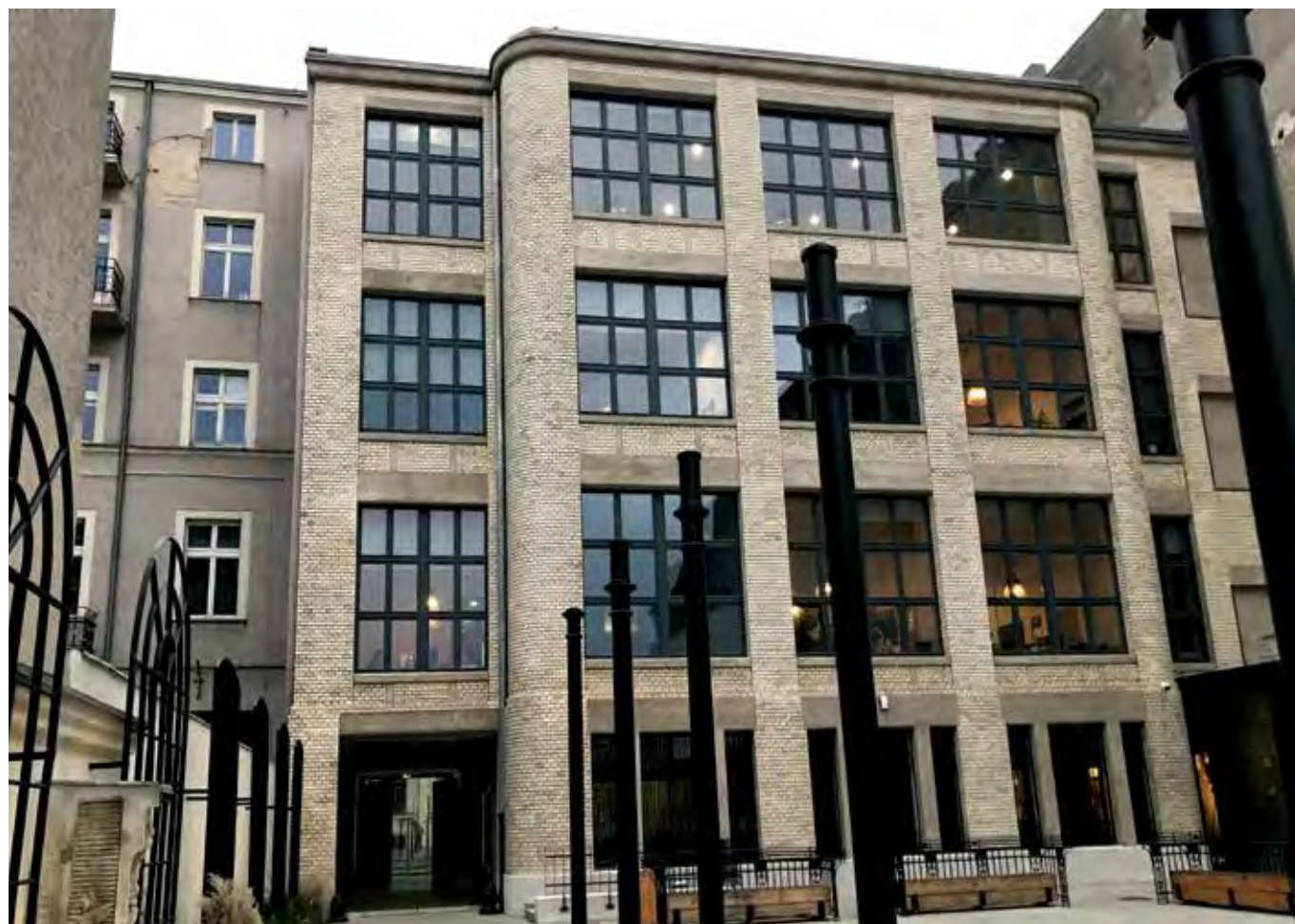
Budynek dawnego domu handlowego Hirszbbergów, elewacja tylna Fot. Ryszard Bonisławski, 2019 r.
