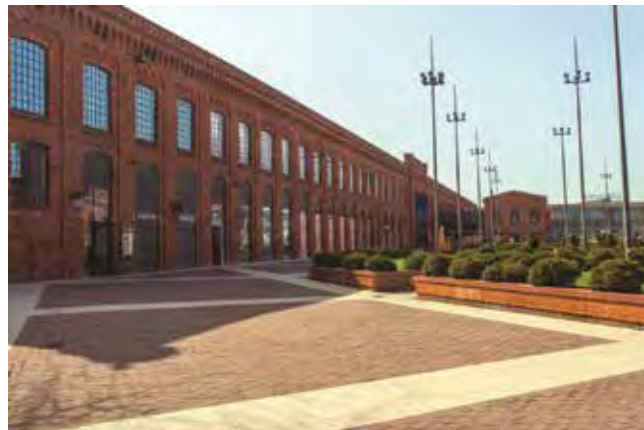
„Manufaktura” (dawna tkalnia niska) – po rewitalizacji Fot. arch. „Manufaktury”
