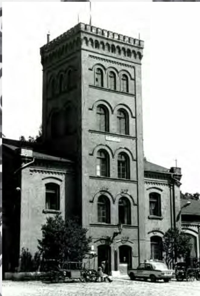
Budynek straży pożarnej na Książym Młynie (ul. 8 Marca - dziś Tymienieckiego) Fot. Andrzej Kuropatwa, 1985 r.
