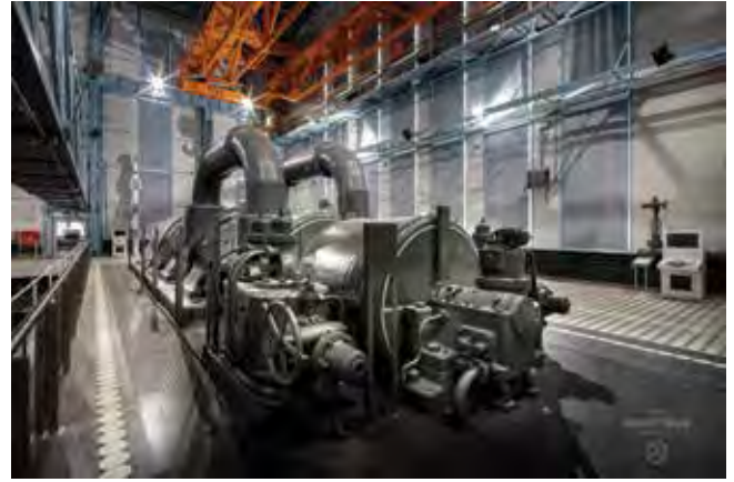
Maszynownia po rewitalizacji Fot. Paweł Augustyniak
