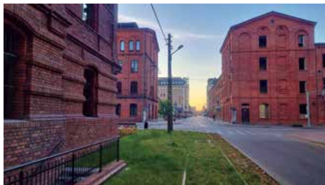
Tory dawnej bocznicy kolejowej prowadzącej z dawnego bielnika w stronę pończoszarni (po prawo) i obu przędzalni (w oddali). Po lewej stronie budynek kantoru Fot. Piotr Tomczyk, 2022 r.
