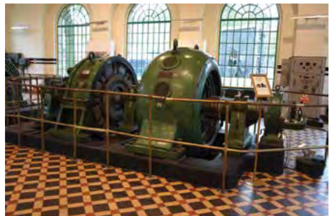
Wnętrze elektrowni, Galeria Sztuki Fot. Ryszard Bonisławski, 2009 r.
