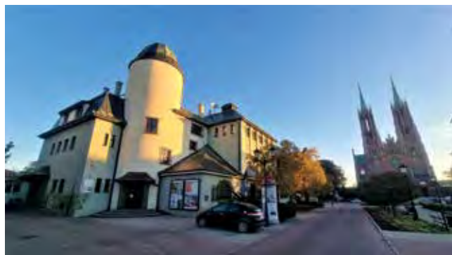
Modernistyczny Dom Ludowy im. Karola Dittricha (tzw. Ludowiec) z 1913 r. i neogotycki kościół farny pw. Matki Bożej Pocieszenia (1900-1903) Fot. Piotr Tomczyk, 2022 r.
