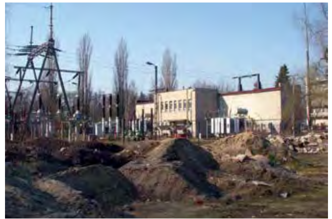
Zrujnowany teren przed powstaniem pola golfowego Fot. arch. A&A, 2009 r.
