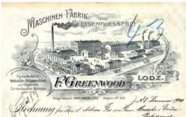
Fabryka Maszyn i Przyborów dla Przemysłu Włókienniczego Fryderyk Greenwood, ul. Dzika (obecnie ul. Sienkiewicza) i ul. Orła (obecnie ul. Orła 1/3)
