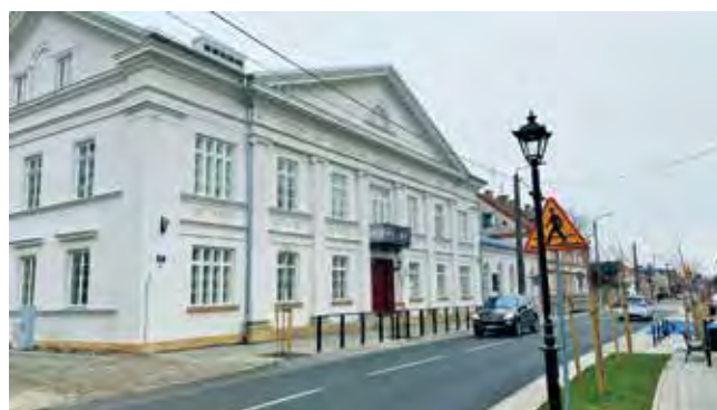
Pałac Fryderyka Schläslera i ul. Listopadowa po remoncie Fot. Izabela Dobrynin, 2019 r.
