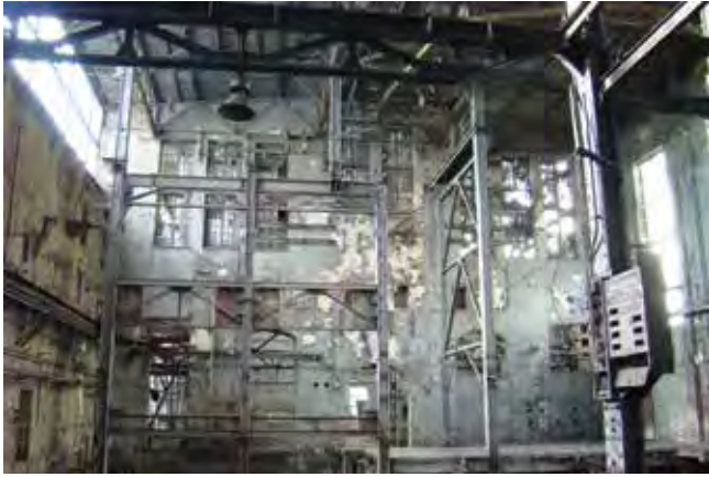
Sala pieców przed rewitalizacją Fot. Ryszard Bonisławski
