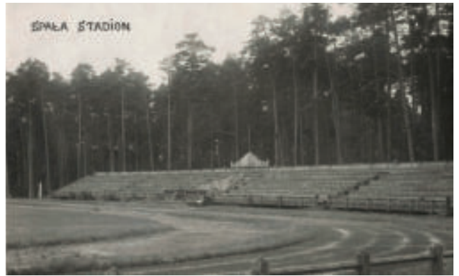
Spała. Stadion zbudowany z okazji spalskich dożynek Fot. z arch. Andrzeja Kobalczyka, 1928 r.
