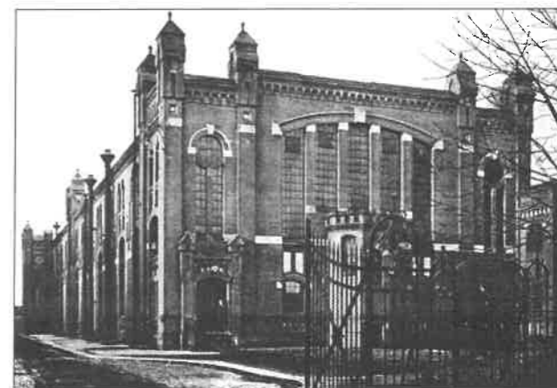
(fot. archiwum) Ogólny widok maszynowni
