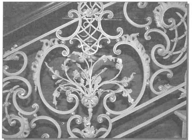
(fot. Filip Tomaszewski; dzięki uprzejmości Wojewódzkiego Konserwatora Zabytków) Detal balustrady
