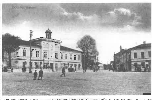
(fot. z arch. Muzeum Miasta Zgierza) W tym miejscu od wieków stał budynek władz miejskich. Widoczny na zdjęciu ratusz zgierski wybudowany został w latach 40. XIX wieku. Piękny klasycystyczny budynek
