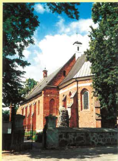
Kościół p.w. Nawiedzenia NMP w Bielawach (fot. Izabela Nowakowska)
