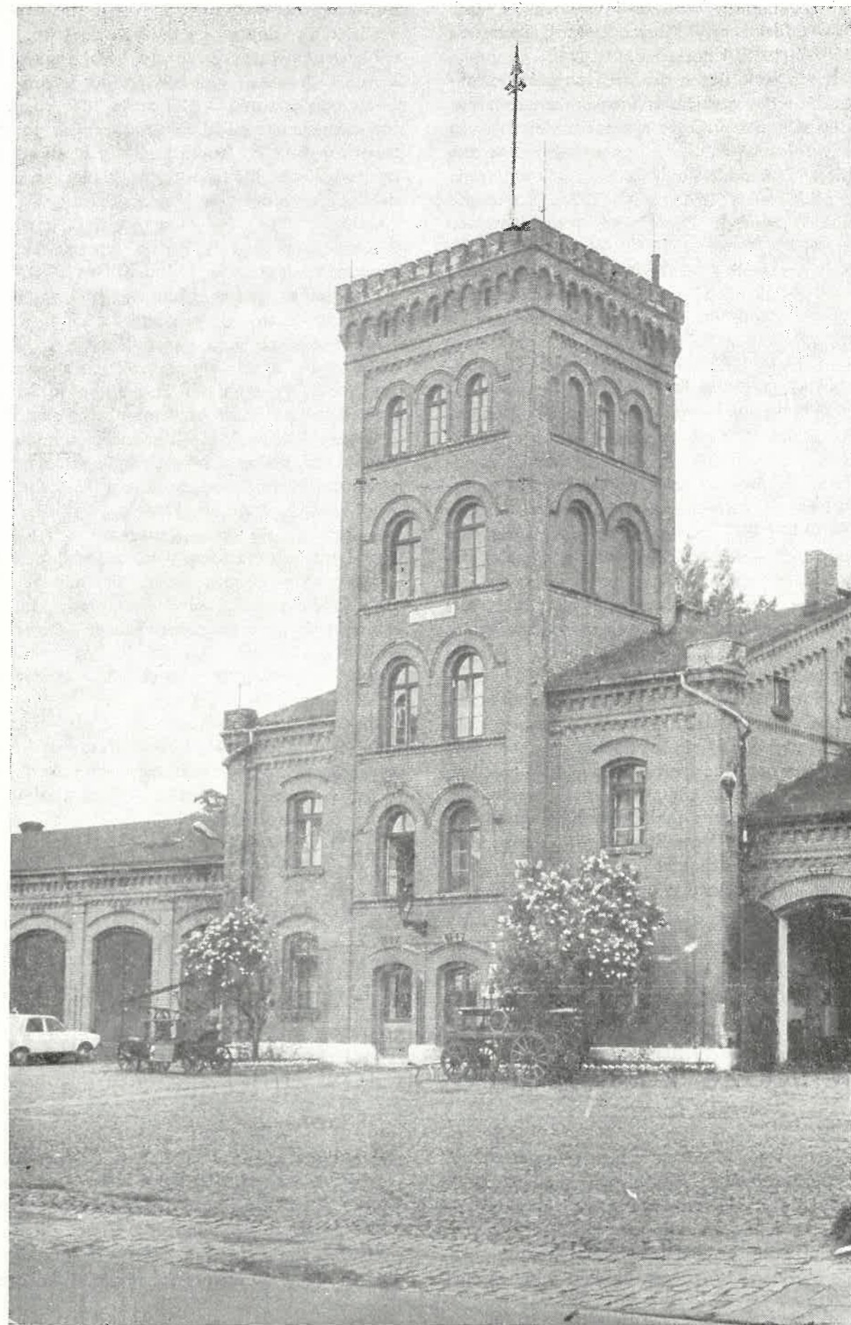
BUDYNEK FABRYCZNY STRAŻY POŻARNEJ K. SCHEIBLERA
