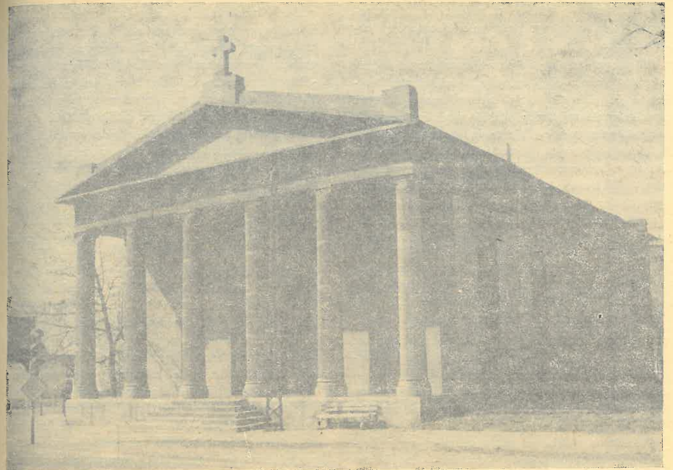
ŚWIĄTYNIA KOŚCIOŁA EWANGELICKO-REFORMOWANEGO przy zbiegu Al. Politechniki i ul. Świerczewskiego
