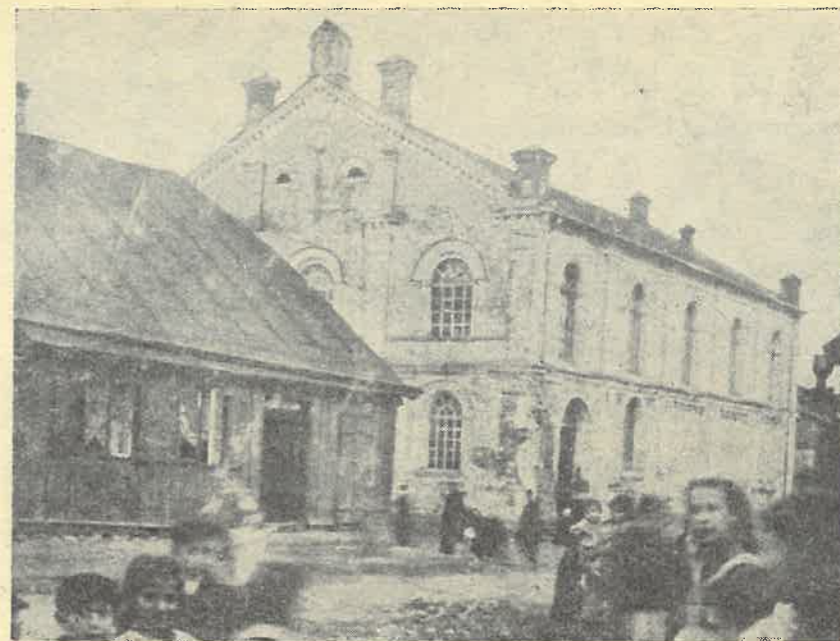
SYNAGOGA PRZY UL. 22 LIPCA (DAWNIEJ RZEŹNICZA) — STAN Z 1908 R.
