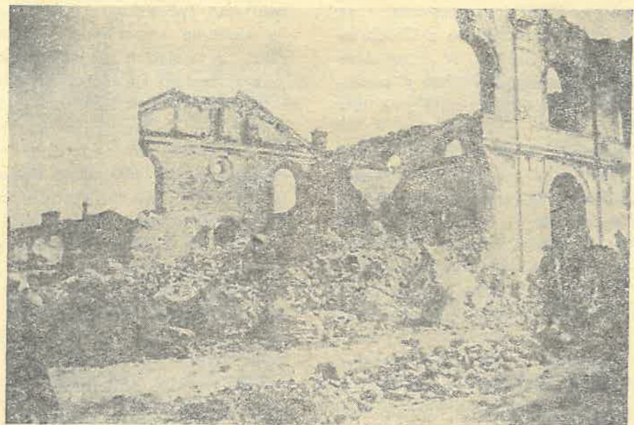
ROZBIÓRKA SYNAGOGI W 1940 R.
