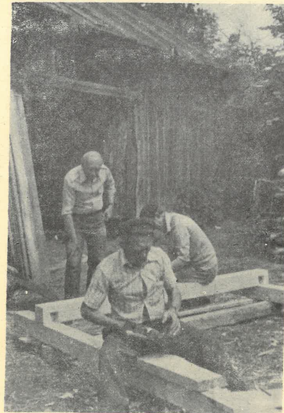
PRACE PRZY BUDOWIE KAPLICZKI
