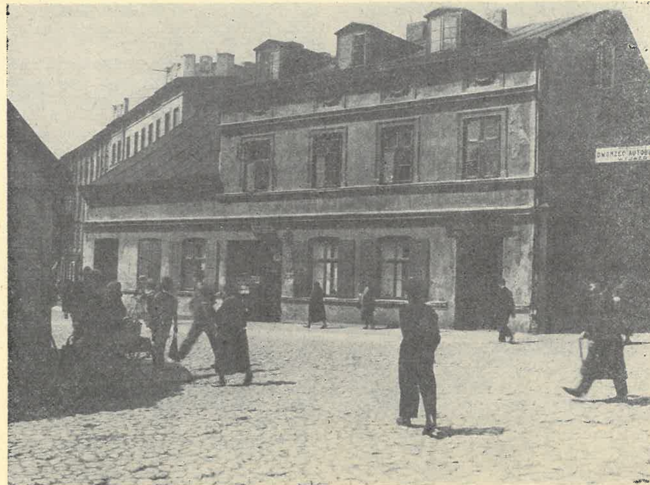
UL. LUTOMIERSKA — DOM RODZINNY DREWNOWICZÓW, 1936
