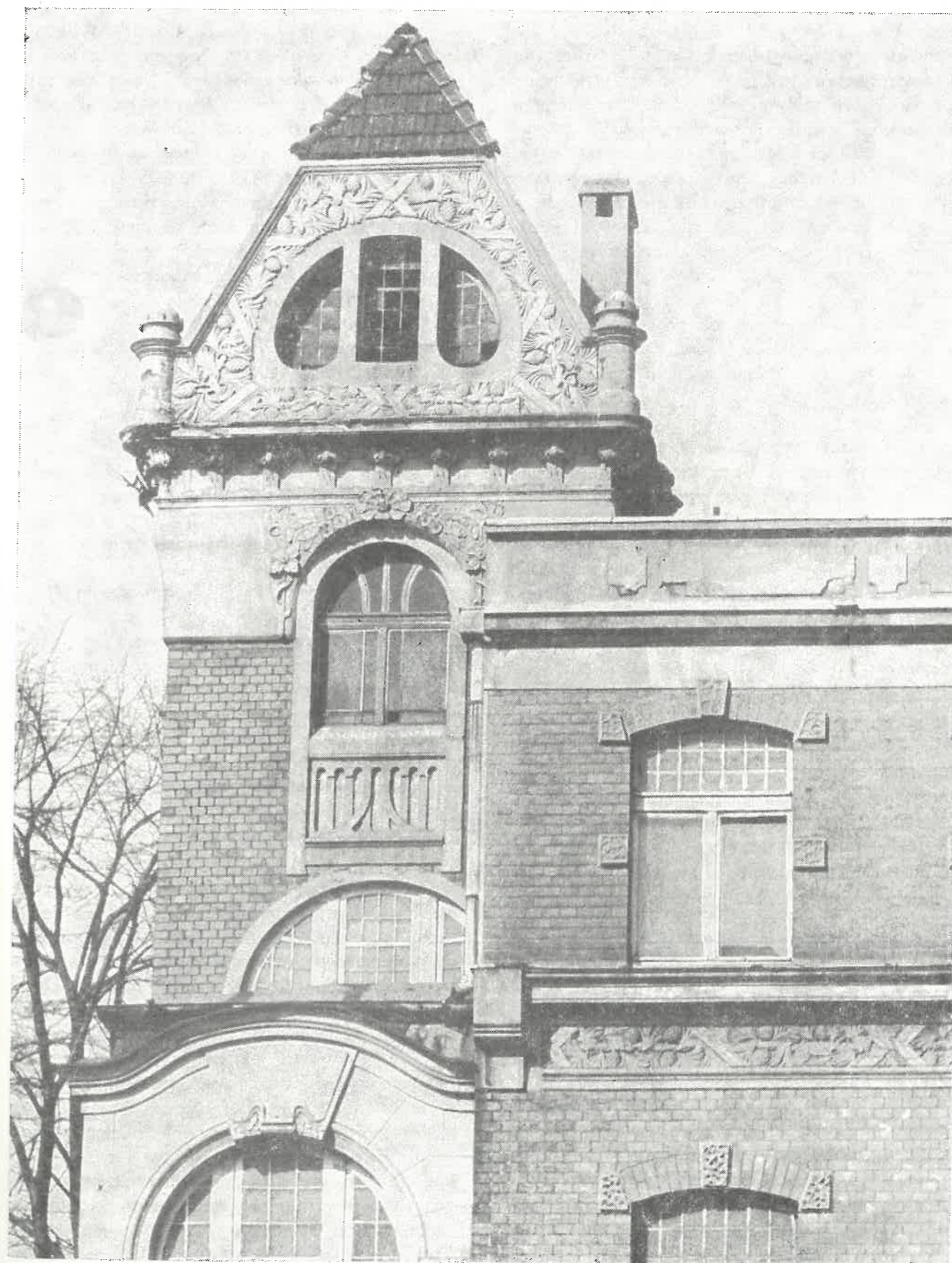
SECESYJNY SZCZYT BUDYNKU PRZY UL. REWOLUCJI 1905 R. NR 44 W ŁODZI
