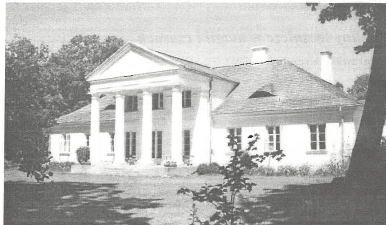
Tulowice k. Sochaczewa Elewacja ogrodowa dworu odbudowanego z ruin przez A. Novaka-Zemplińskiego
